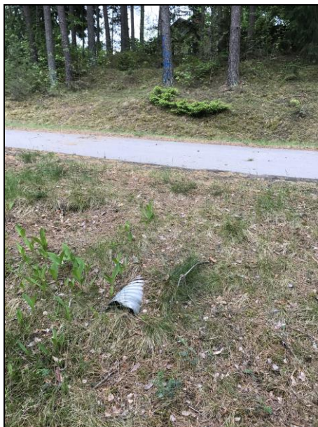
Figur 18. Trumma under GC-vägen
