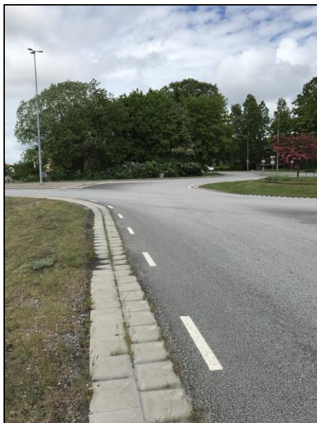
Figur 10. Det vägdagvatten som inte rinner över till grönytan väster om vägen, samlas i mitten av cirkulationsplatsen där det finns en rännstensbrunn som är ansluten till dagvattennätet.
