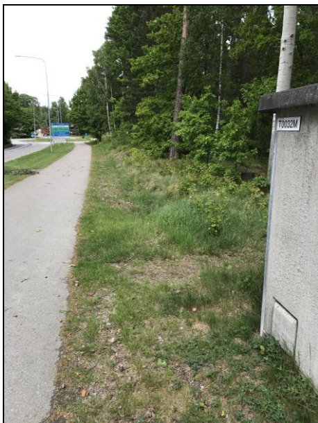
Figur 12. Diket vid GC-banan. Till höger i bild ses elstationen.
