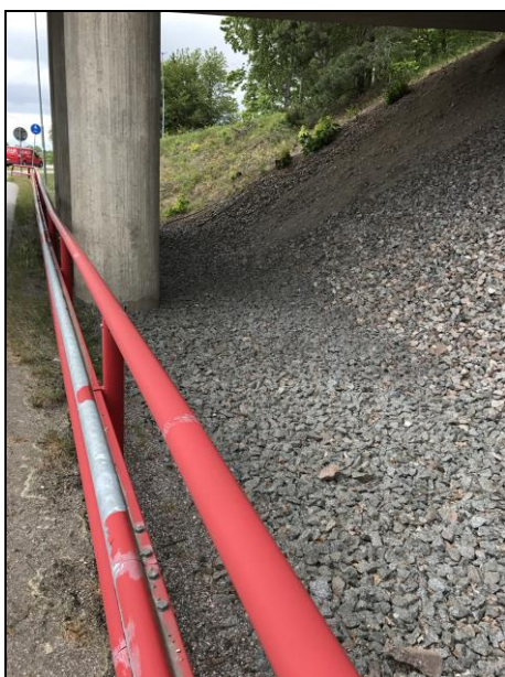
Figur 14. Dike/makadamdike under gamla järnvägsbron vid slutningen mot Södra Bålstaleden
