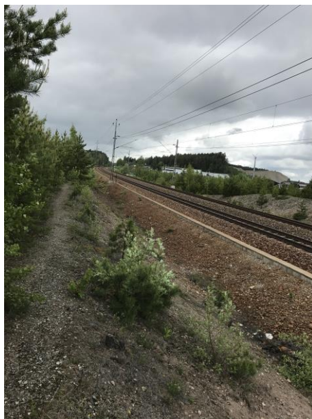
Figur 22. Järnvägen med dike
