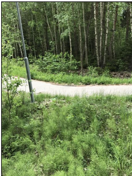
Figur 23. En dagvattentrumma avvattnar området norr om GC-vägen till lågområdet i söder
