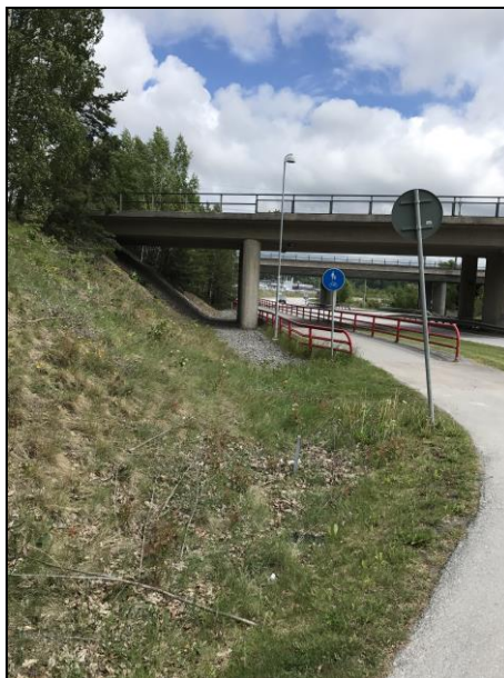
Figur 13. Den f.d. järnvägsviadukten
