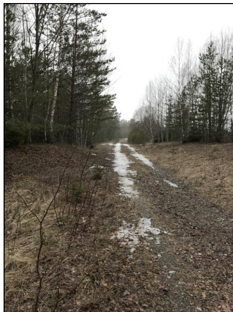
Figur 20. Den f.d. järnvägsbanken
