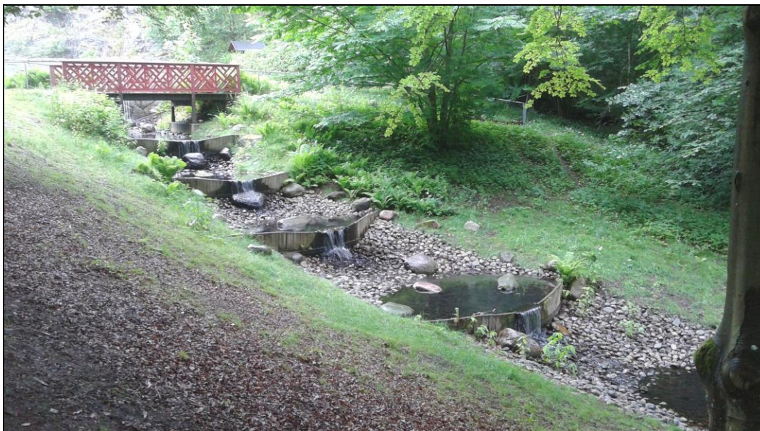
Figur 29. Sektionerat dike med överfall, Slottsskogen i Göteborg (Foto: Norconsult)
